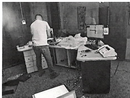
Elaboración de cableado para conectividad de consola y equipo periférico
