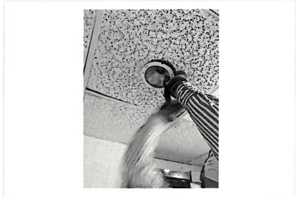
Cambio de soporte para luminaria
