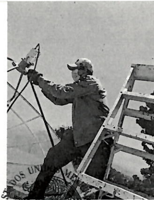
Se realiza limpieza y ajuste de "LNB"
