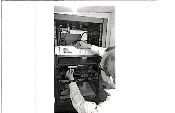
Limpieza en seco a electrónica
