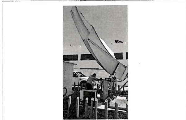
Ajuste de tornillería en la inclinación de la antena
