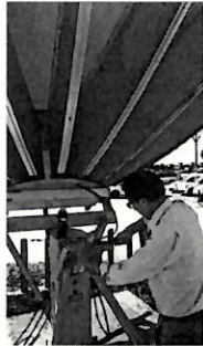
Ajuste de tornillería en antena transmisora.
