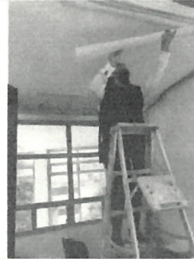
Limpieza de alumbrado
