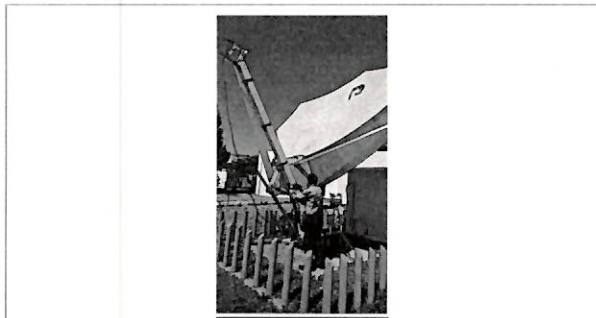
Ajuste de tornillería en el azimut de la antena
