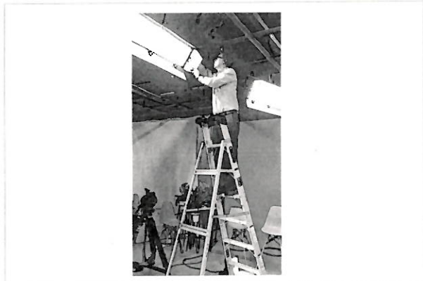
Limpieza de lámpara frontal de "Green Screen"
