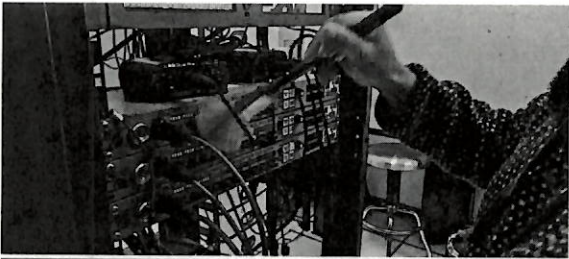
Limpeza en seco a sistema de intercomunicación de las cabinas
