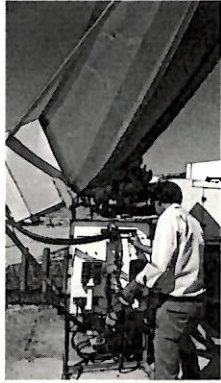
Aplicación de líquido anticorrosivo en tornillos de fijación.
