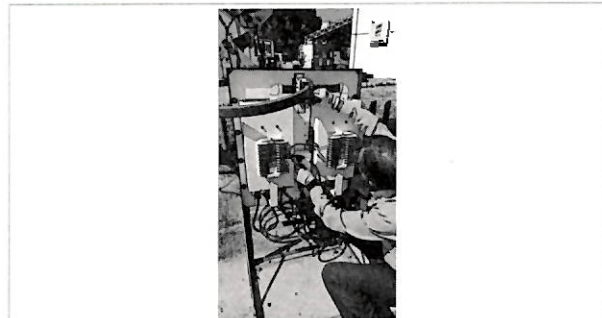
Ajuste de tornillería en los amplificadores
