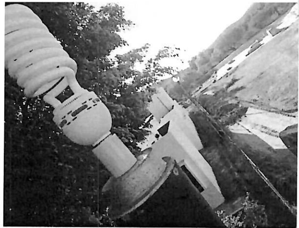
Se sustituye lámpara de estacionamiento, se retira sistema antiguo de balastro, por ser caro y obsoleto, y se adapta lámpara ahorradora
