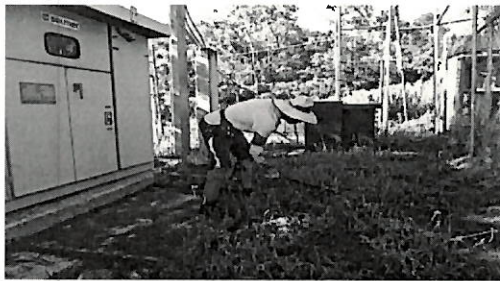
Se realizó limpieza a áreas verdes de la subestación eléctrica
