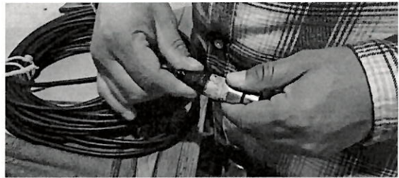
Reemplazo de conectores en líneas de audio
