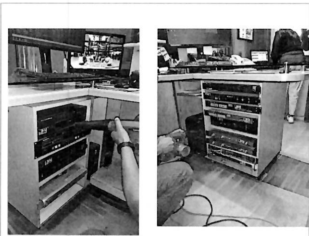
Retiro de polvo del equipamiento en cabina de transmisión y limpieza de equipo
