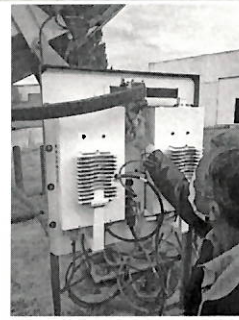
Revisión de tornillería a amplificadores
