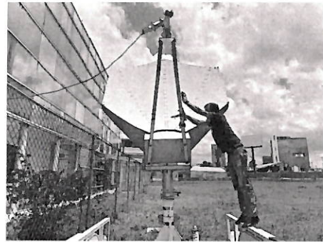
Ajuste de soporte de "LNB" de antena terrena
