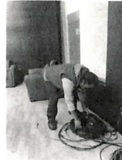
Orden de cableado
