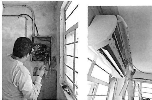
Limpeza y aspirado de tablero eléctrico principal, y de filtros del equipo de enfriamiento en caseta de transmisión
