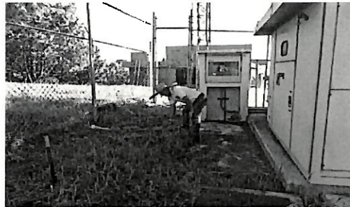
Se realizó limpieza a áreas verdes de la subestación eléctrica
