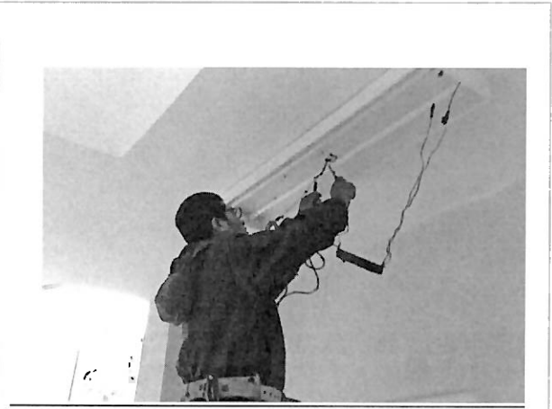
Cambio de balastro y tubos de luz
