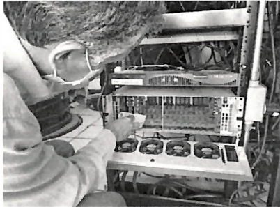
Limpeza a ventiladores del insertor de tablas
