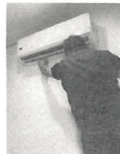
Limpieza de aire acondicionado
