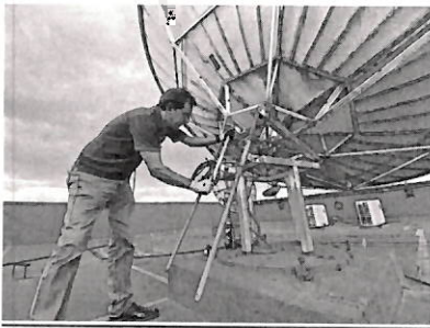
Chequeo de tornillería en antena
