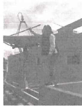
Limpieza de antenas
